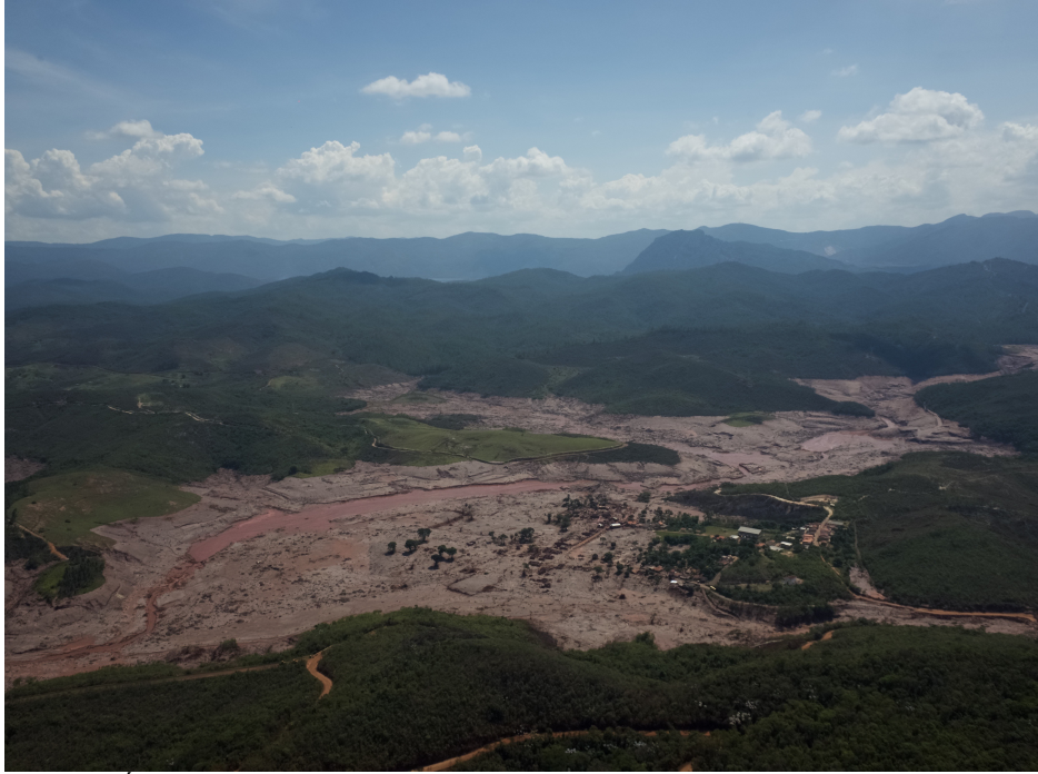
Figura 4: Área impactada imediatamente à jusante da barragem de Santarém. Barragem de Fundão após o rompimento. Foto: Ibama
