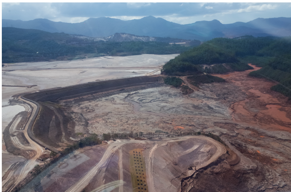
Figura 3: Barragem de Fundão após o rompimento. Foto: Ibama
